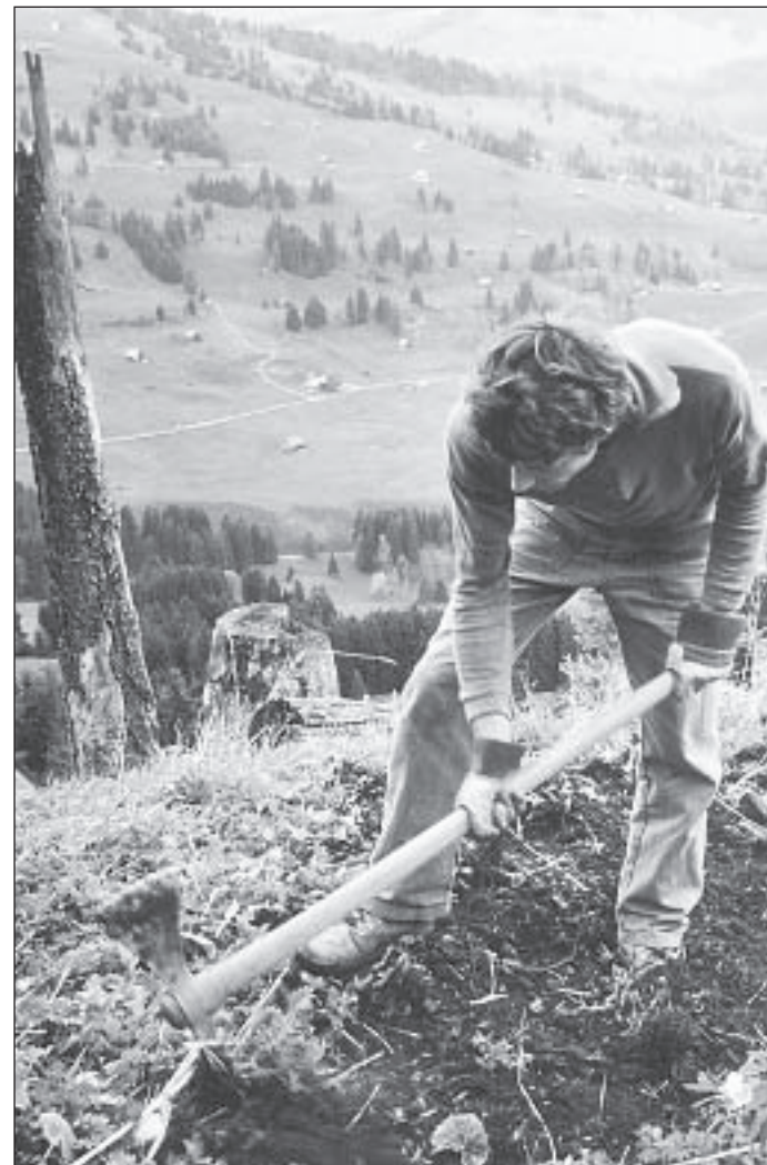
Wegebau in Werdenberg bei Grabs.
